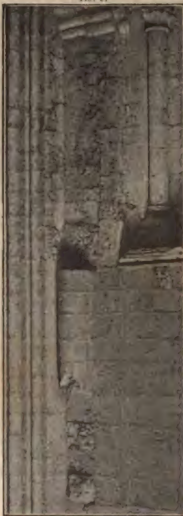
COLONNE D'ANGLE DU CLOCHER SUD
